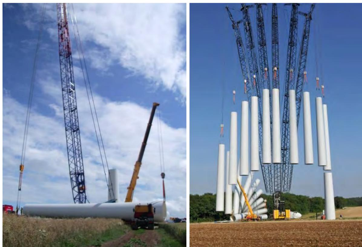
Figure 6 : Illustration du montage des éoliennes Source : Q ENERGY
