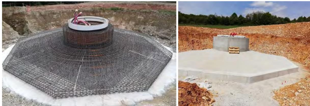
Figure 5 : Illustration de la construction d'une fondation (Source : Q ENERGY)
